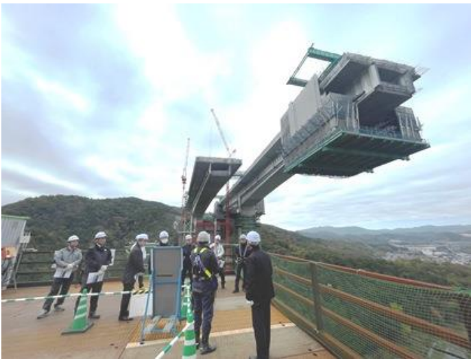
作業高台で説明を受ける (張り出し式仮設工法)
